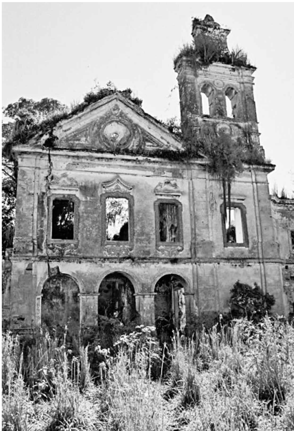
Figura 5 – Fachada da igreja conventual
