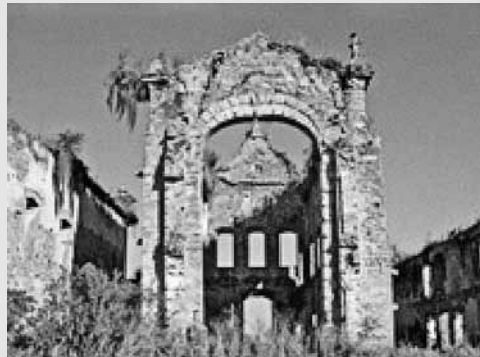
Ruínas do convento São Boaventura, no distrito de Porto das Caixas, no município de Itaboraá (fotos Edson Lima)
