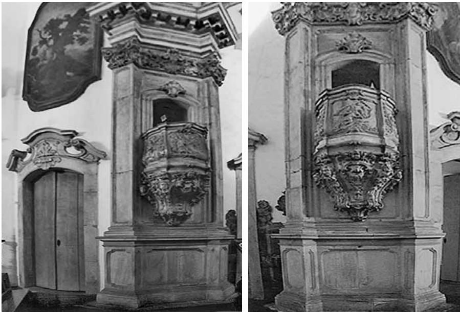
Figura 3 – Os Púlpitos no intradorso do Arco do Cruzeiro e Acesso para os púlpitos junto ao Altar Mor
