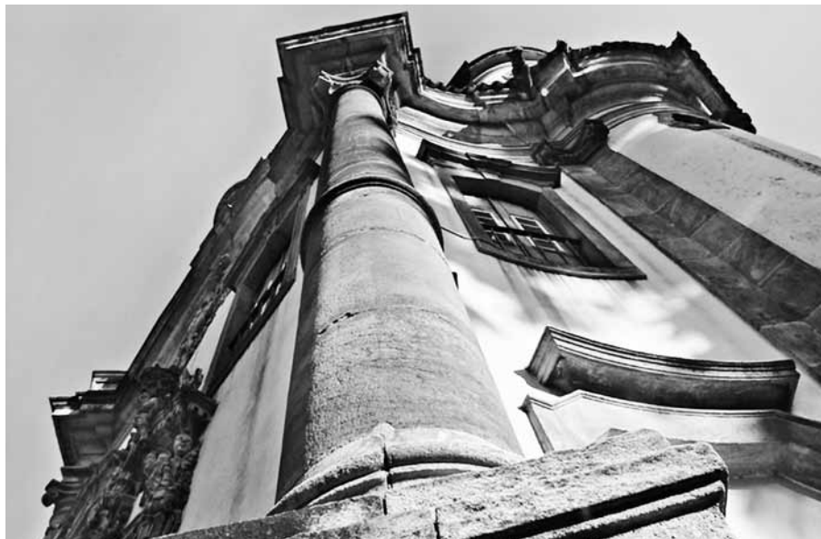
Figura 2 – Curvas e contra-curvas que conformam a fachada principal
