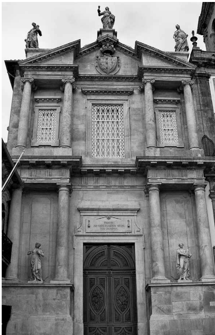
Figura 2 Porto. Igreja da Venerável Ordem Terceira de São Francisco (Foto: autor)
